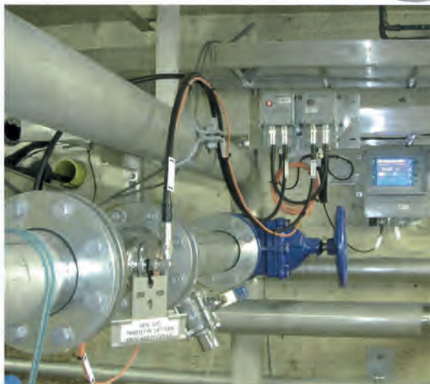
Die exakte Bestimmung der Durchflussmenge ist für eine zuverlässige Steuerung der richtigen Dosierung unerlässlich. Mithilfe des \mu -ICC 2.45 COMPACT-Messgerätes kann die Schlammichte beziehungsweise die Trockenmasse online erfasst werden.
