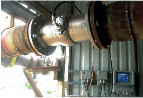
Im Gegensatz zu vielen anderen Verfahren ist die Sensorik der Mikrowellen-Transmission im Stande, trotz Belagbildung exakte Messergebnisse zu liefern. Trübung, Feststoffe oder Inkrustationen wirken auf die Mikrowelle nicht ein.
